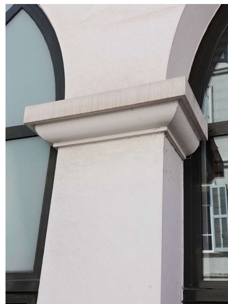
Détail d'un habillage de colonne en façade de l'Hôtel Majestic - Cannes - Acrystal Prima + fibre Acrystal 200-4D - Panneaux stratifiés de +/- 7 mm d'épaisseur
